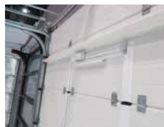
Detalle del muelle retenedor y la omega de refuerzo.
