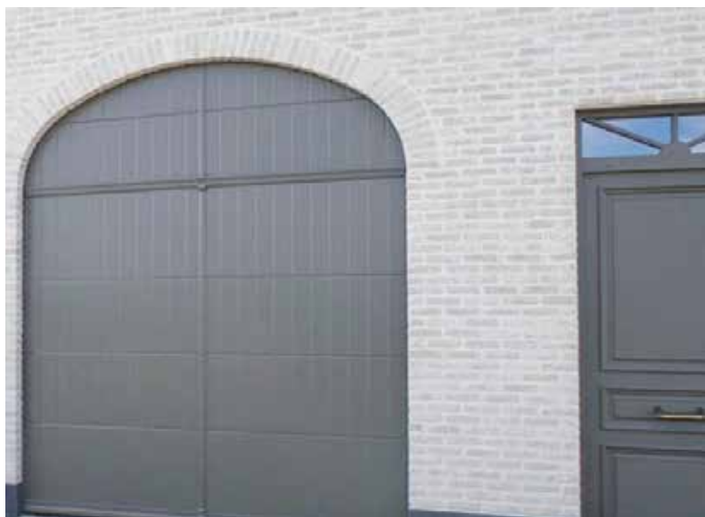
* Puerta seccional con apariencia de puerta batiente de doble hoja.
