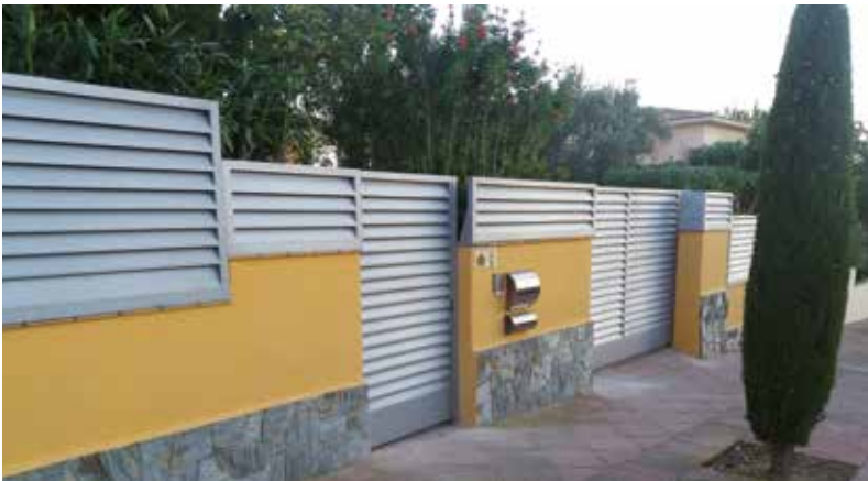
Conjunto de valla y puerta peatonal de librillo horizontal galvanizado.
