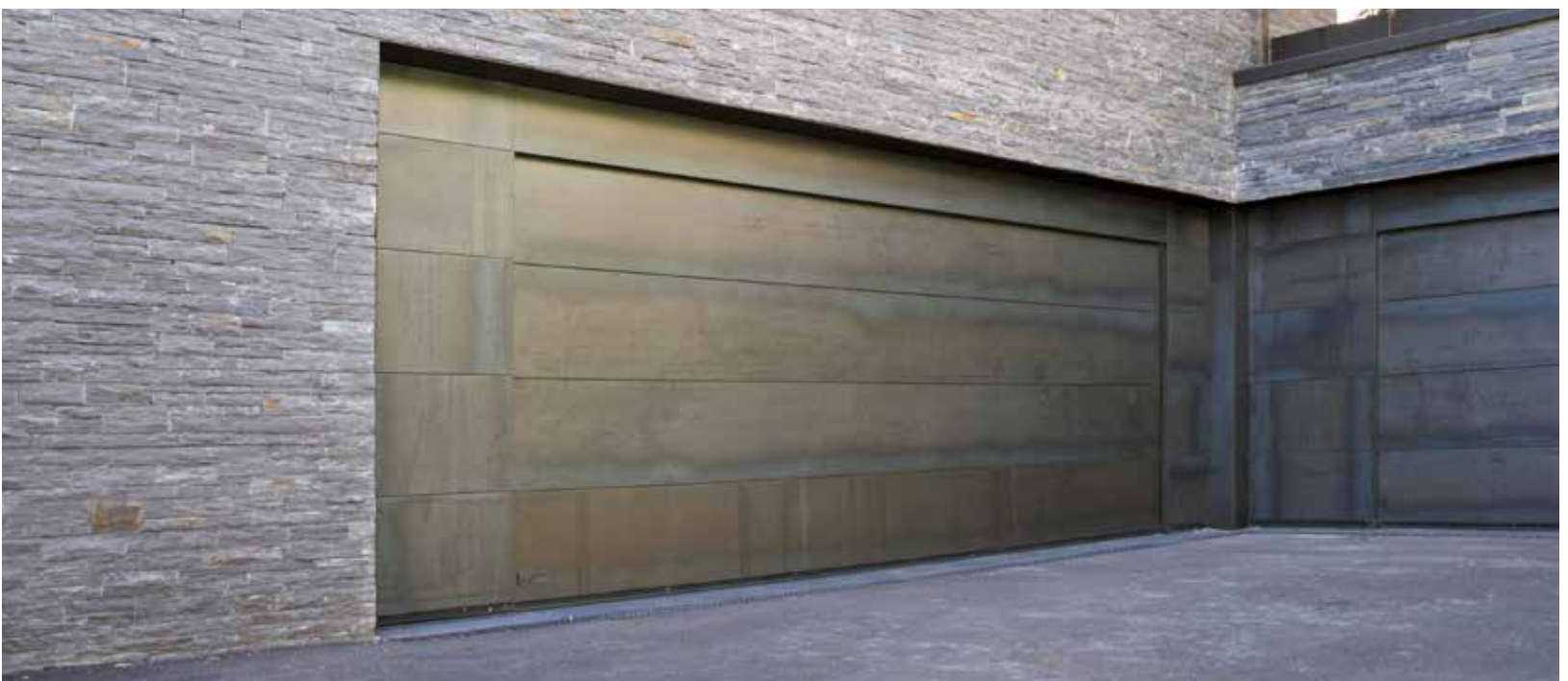
Los estados de oxidación de cada puerta se reflejan en las diferentes tonalidades de los paneles.
