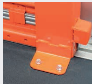
Refuerzo con anclaje al suelo.
