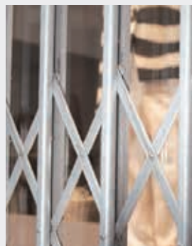
Detalle de la puerta ballesta de acero.
